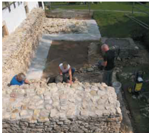
Treppenfundament des Isistempls am Frauenberg, Reinigungs- und Sanierungsarbeiten im Jahr 2009
