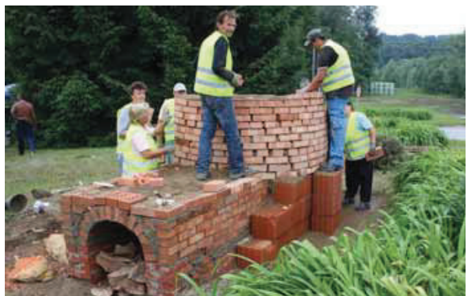
Die Errichtung des Kalkofens in Retznei im Juni 2010
