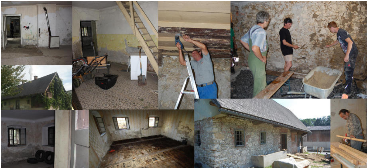
Rauchstubenhaus Retznei 26 vor und während der Revita- lisierungsarbeiten
