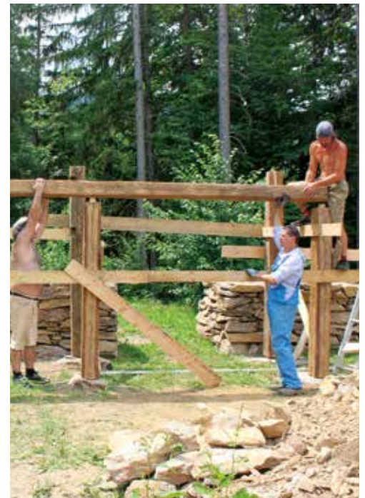
Errichtung einer Halle auf dem Areal der Burg Schwanberg, Foto: © ASIST / Bernhard Schrettle
